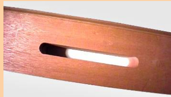
Défonçage des ventilations
