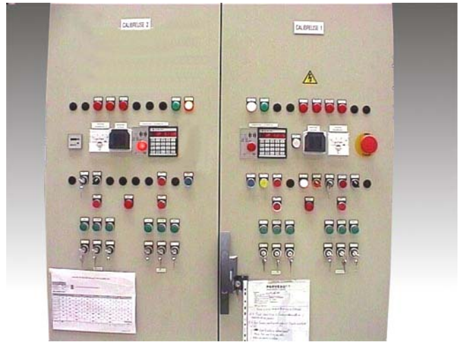
Vue de détail du pupitre de commande. Celui-ci contrôle l'ensemble des porte-outils des 2 calibreuses doubles.
