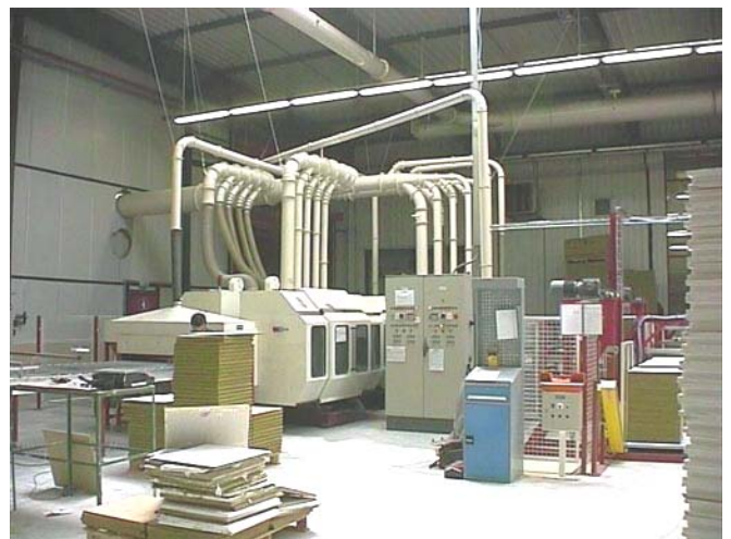
Vue d'ensemble de la ligne. Au centre le pupitre de commande.
