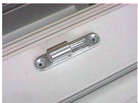
Platine fiche sur profil dormant avant vissage définitif.
