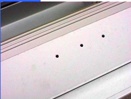
Vue des trous des platines fiche percés dans l'aluminium.
